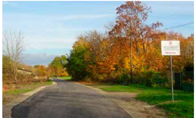
Przebudowa drogi Jasieniec Kolonia – Podborek.
