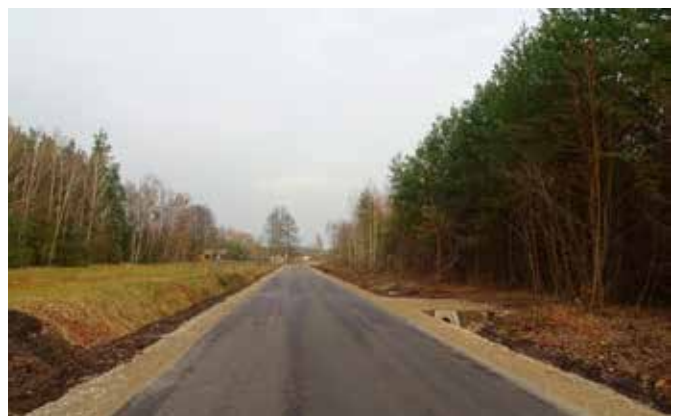
Przebudowany odcinek drogi gminnej Miodne - Linów.
