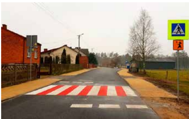
Wyremontowana droga gminna w Koszarach
