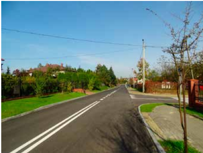
Ulice Reja po przebudowie.
