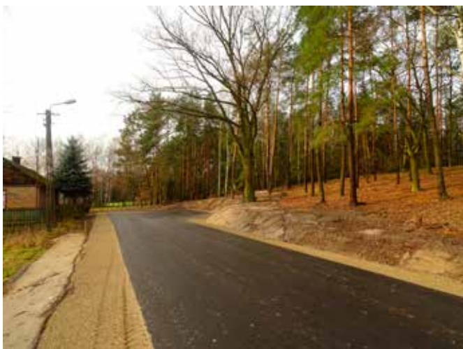
Przebudowa drogi w Waclawowie.
