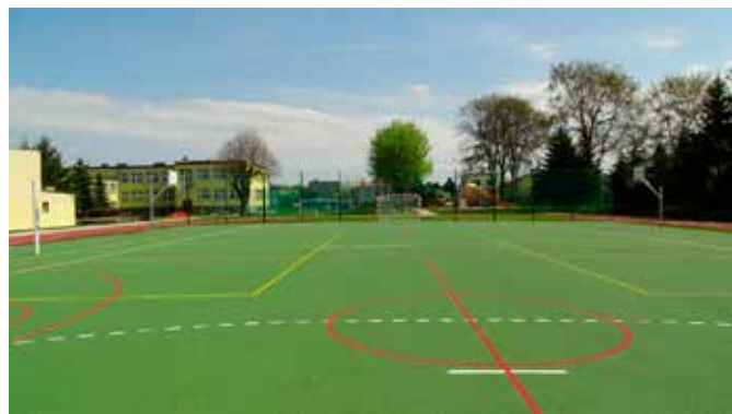
Boisko po modernizacji.
