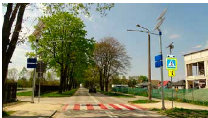
Bezpieczne przejście dla pieszych w ul. Sienkiewicza.
