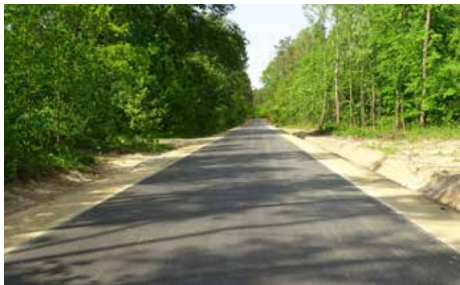
Widok drogi po przebudowie.
