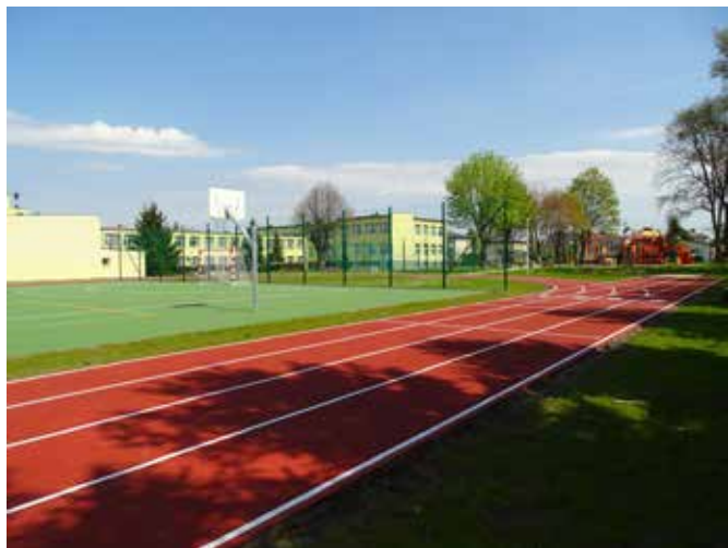
Trzytorowa bieżnia z nawierzchnią poliuretanową o dystansie 200 metrów, z wyznaczonym odcinkiem prostym oraz rozbieżnią do skoku w dal.
