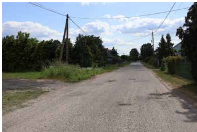
Droga w Strykowicach Górnych przed rozpoczęciem przebudowy.
